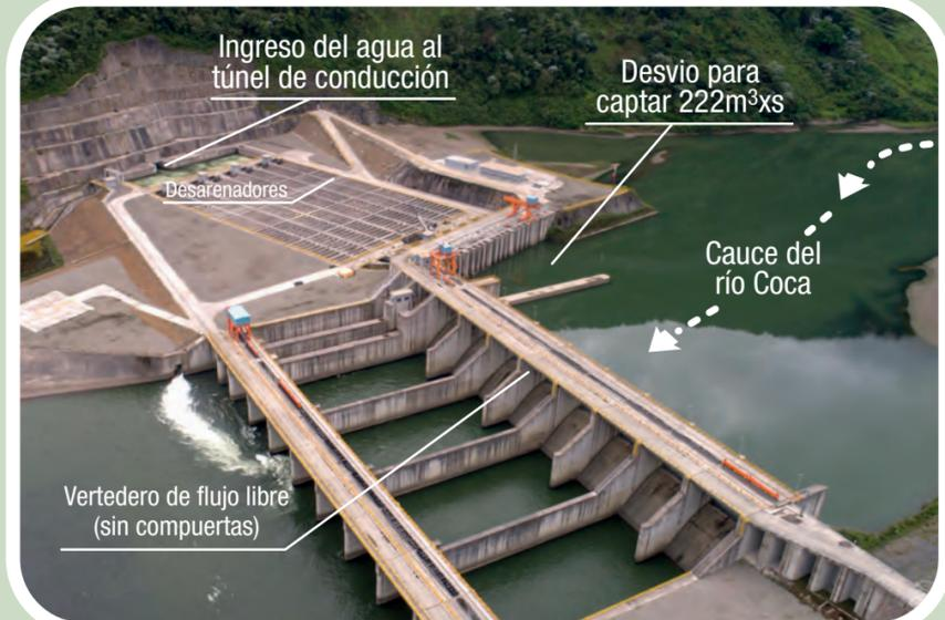
Las obras de captación permiten el paso del caudal (excesos de agua y sedimentos que arrastra el río) a través de un **vertedero de flujo libre**. Hay equipos de monitoreo en tiempo real.
